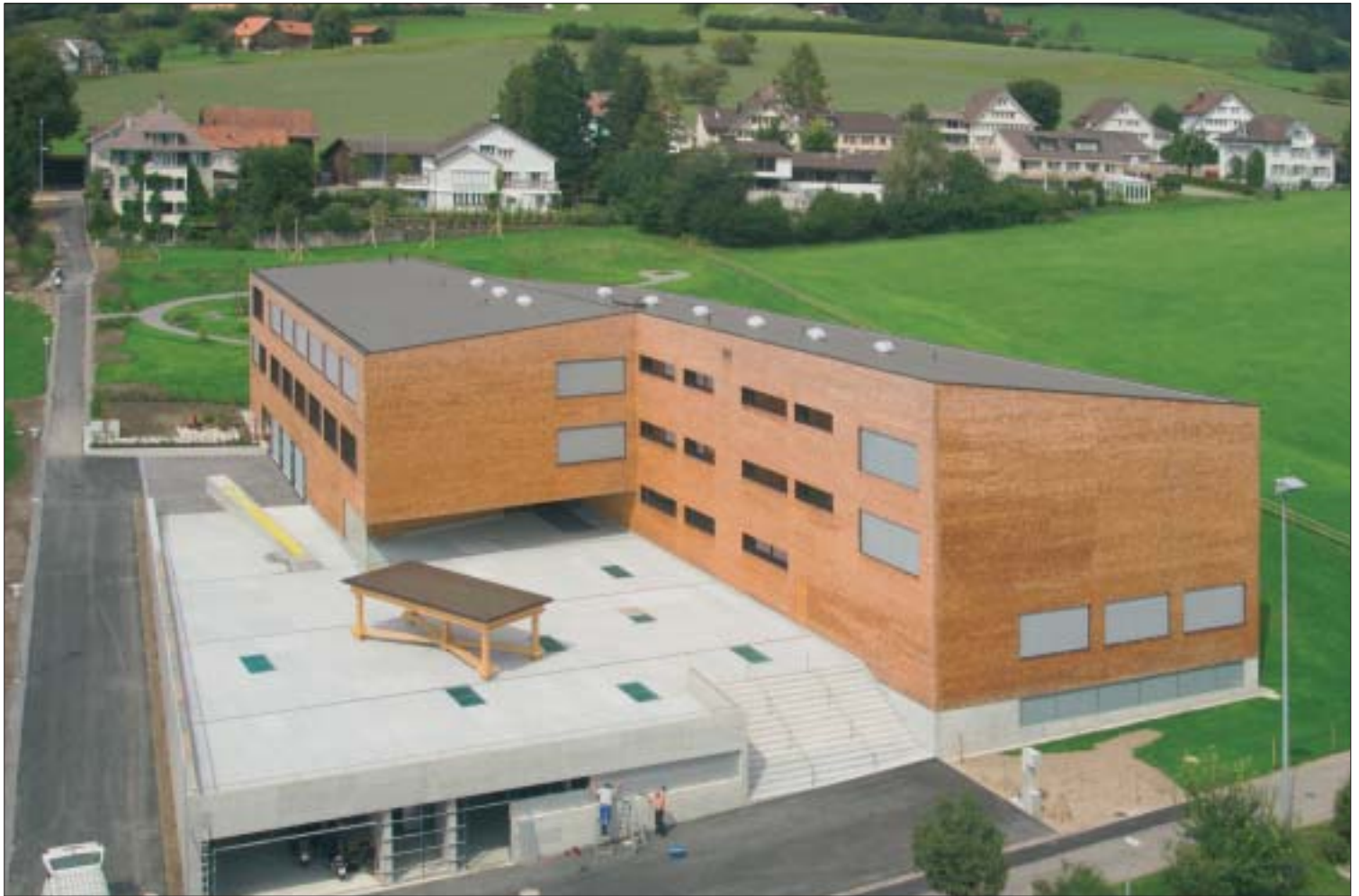
as neue Schulhaus Landhaus von Südwesten, fotografiert von der neuen 35-Meter-Autodrehleiter der Feuerwehr Teufen-Bühler-Gais.
