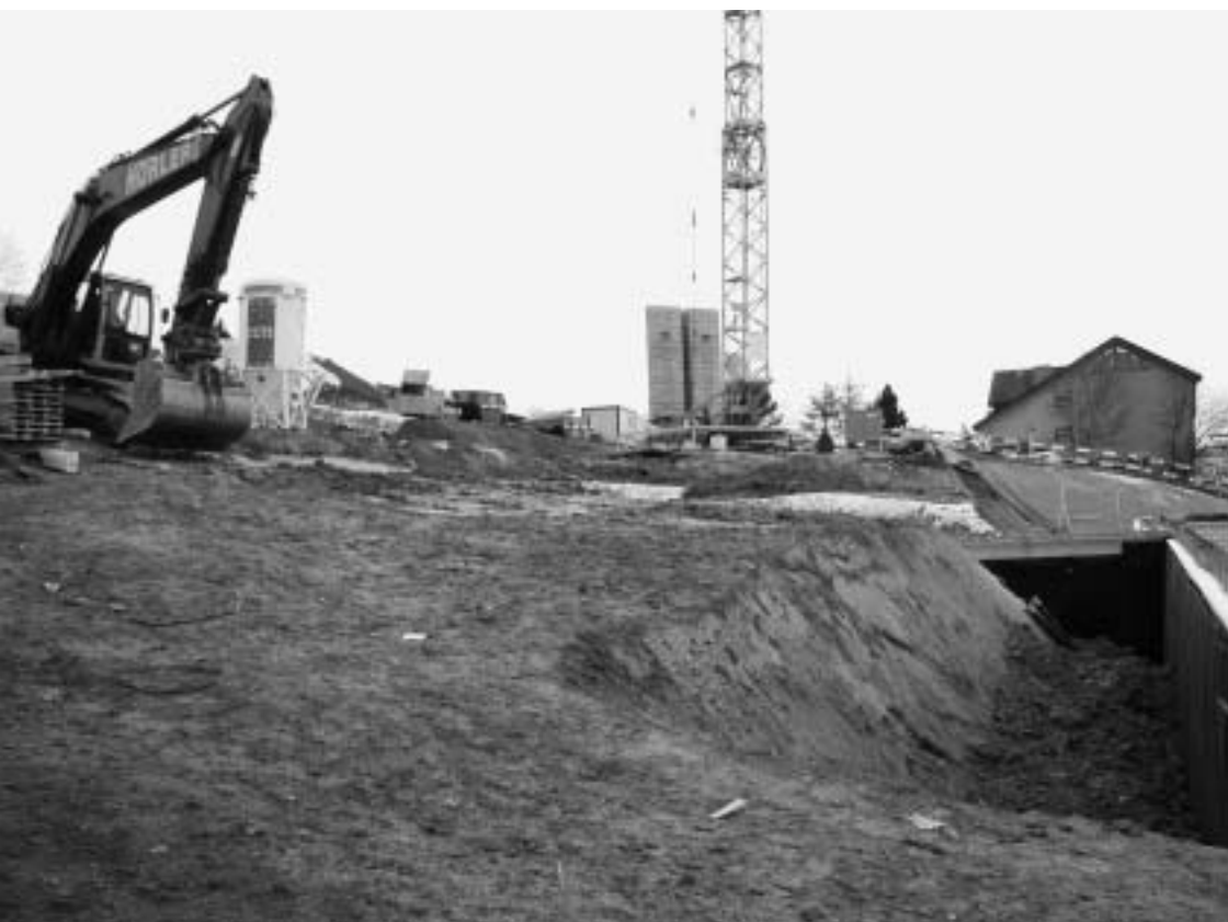
In Teufen wird fleissig «die Hand geändert» – im Bild Wohnungsbau Auf dem Stein in Nieder-teufen. Foto: GL
